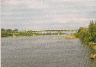
Przeprawa pod Górą Kalwarią
